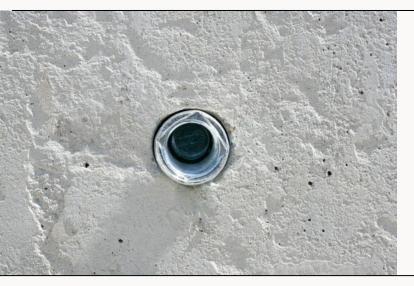
**DROP-IN** INTERNALLY THREADED ANCHOR
